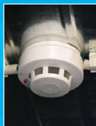
Датчик системы пожарной сигнализации
