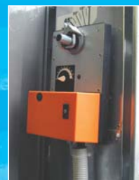
Автоматический привод управления вентиляционными жалюзи
